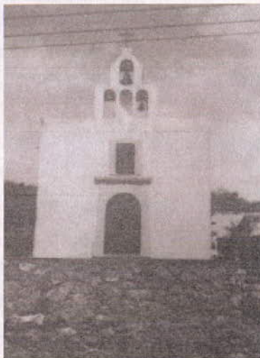
Figura I.4.24 Fachada principal de la Capilla de Santa María de Guadalupe.
