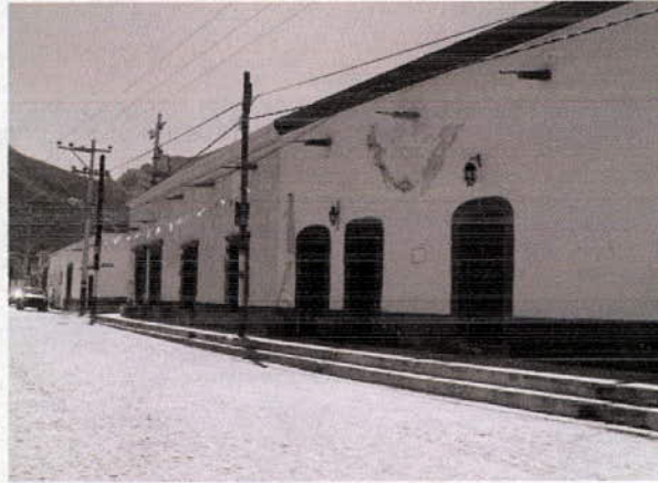
Figura I.4.29 Arquitectura civil ubicada en la calle principal de Peñamiller.
